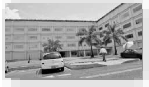
Figura 1: Hospital Internacional de Barquisimeto (HI).
